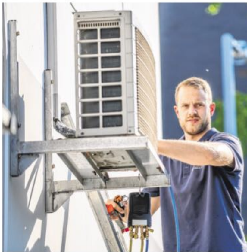
Klimatechniker Philipp Janz montiert ein Klimagerät an der Hauswand. Die Firma Zeller, bei der er arbeitet, hat alle Hände voll zu tun.
